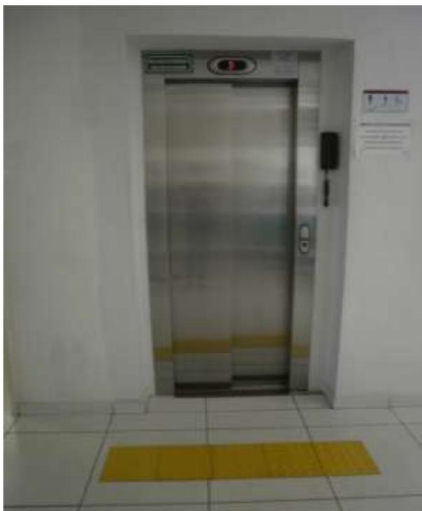
**Figura 03:** Elevador exclusivo para pessoas com necessidades especiais ou deficientes, conforme Art. 27: *A instalação de novos elevadores ou sua adaptação em edificações de uso público ou de uso coletivo, bem assim a instalação em edificação de uso privado multifamiliar a ser construída, na qual haja obrigatoriedade da presença de elevadores, deve atender aos padrões das normas técnicas de acessibilidade da ABNT.*
