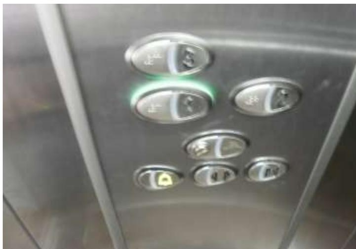
**Figura 04:** Elevador com botoeiras em braile, conforme Art. 27, 2º *Junto às botoeiras externas do elevador, deverá estar sinalizado em braile em qual andar da edificação a pessoa se*
