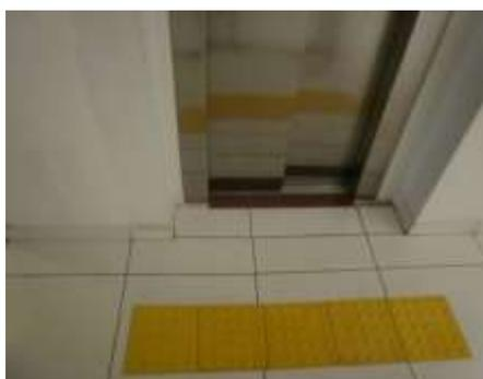
**Figura 06:** Piso tátil instalado próximo à porta do elevador exclusivo para pessoas com dificuldade de locomoção
